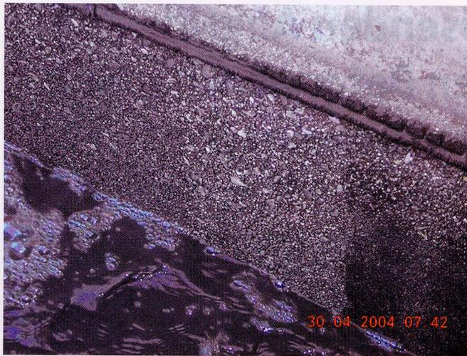
Kläranlage VKA Saalfelden – Betonkorrosion in der Wasserwechselzone der Rücklaufschlammrinne des Nachklärbeckens (Foto: Thorer)
